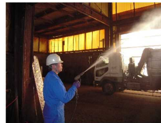
原料置場・工場棟への消臭作業
