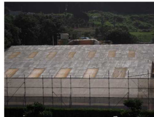
工場屋根・側面 発泡ウレタンを塗布
